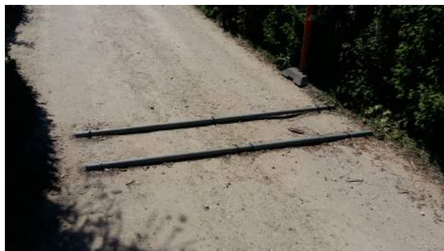
Vejbump 2: 2 jernstænger hvor der er hul i midten så cykler, barnevogne og trillebøre kan passere.
