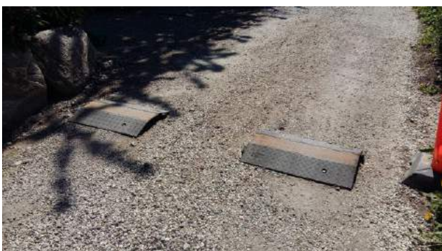
Vejbump 1: kantede vejebump i plast der vil blive placeret forskudt for at skåne billernes undervogn.
