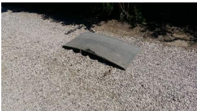
Vejbump 3: blødt vejebump i plast der vil blive placeret forskudt for at skåne billernes undervogn.
